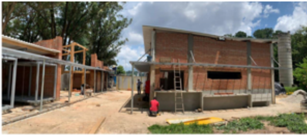
Vista a partir da "Praça Carajás": dens (esq), library (fundo) e Troop room (dir)
