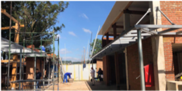
Obras no Library (esq)
