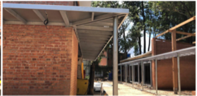
Preparação das estruturas de marquises
